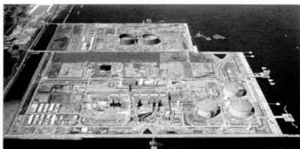
上越火力建設工事全景
