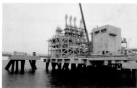
LNG受入棧橋
