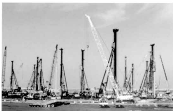
発電設備基礎杭打ち(平成19年11月)
