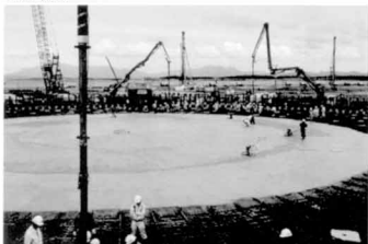
LNGタンク基礎版コンクリート打設(平成19年10月)
